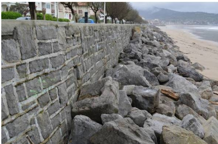
La digue de protection des dunes réalisée par la 1 ère société, en 1885
