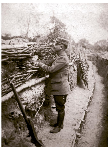
Pierre dans sa tranchée
